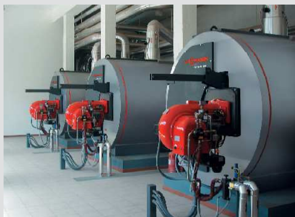
Водогрейный котел Vitomax 300-LT в эксплуатации.
